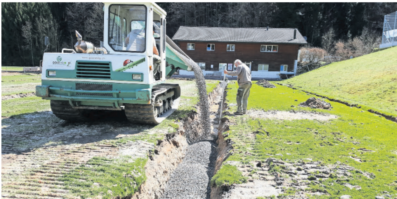
2018 ist das Rasenfeld der Sportanlage Löösch saniert worden.
