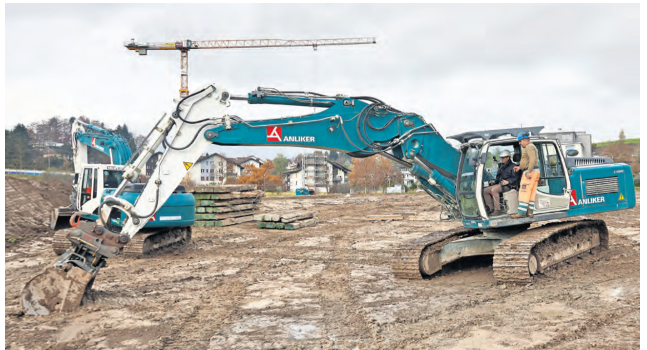
Finanzvorsteher Pascal Ludin genoss die Ehre, die erste Baggerschaukel in das weiche, lehmige Erdreich im Dorfzentrum zu stechen. BILDER TOM STOCKER
