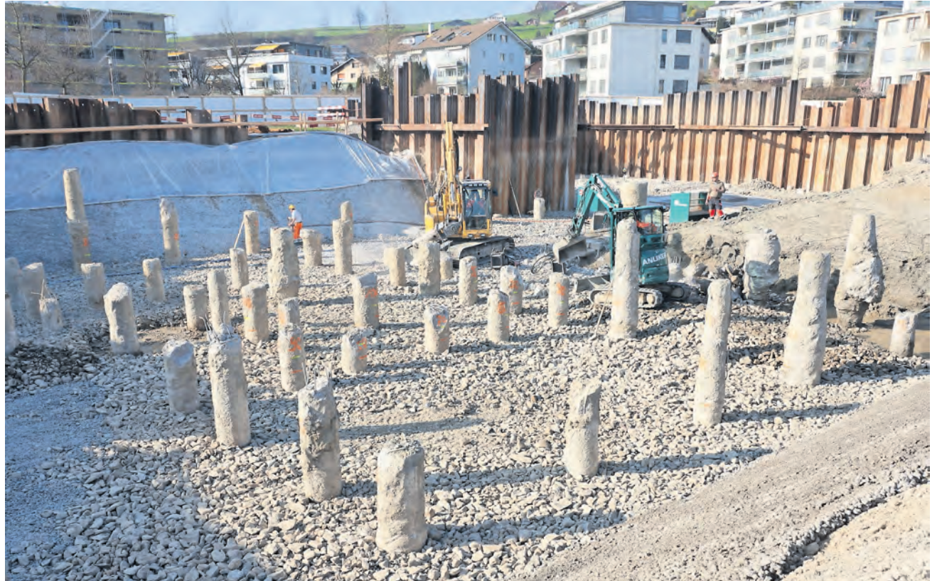
Die AGZ-Baugrube im Zentrum von Adligenswil: Dicht nebeneinander ragen die Pfähle aus dem Untergrund.
