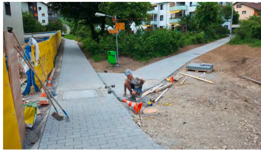
Das erste Teilstück des neuen Fussweges ist bereits fertiggestellt.
