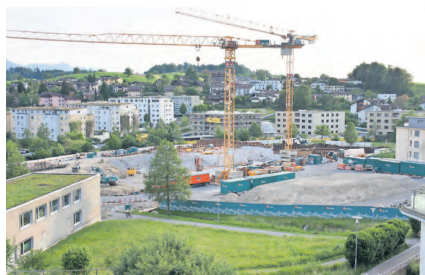
Die Baustelle des AGZ im Dorfzentrum.
