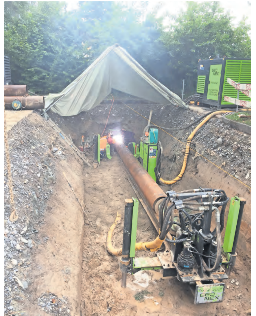
Das Bohrgerät mit dem Eisenrohr, das unter dem Fussballplatz im Zentrum hindurchgetrieben wird. In dieses Rohr werden die Heizleitungen und das Steuerkabel eingeführt.
