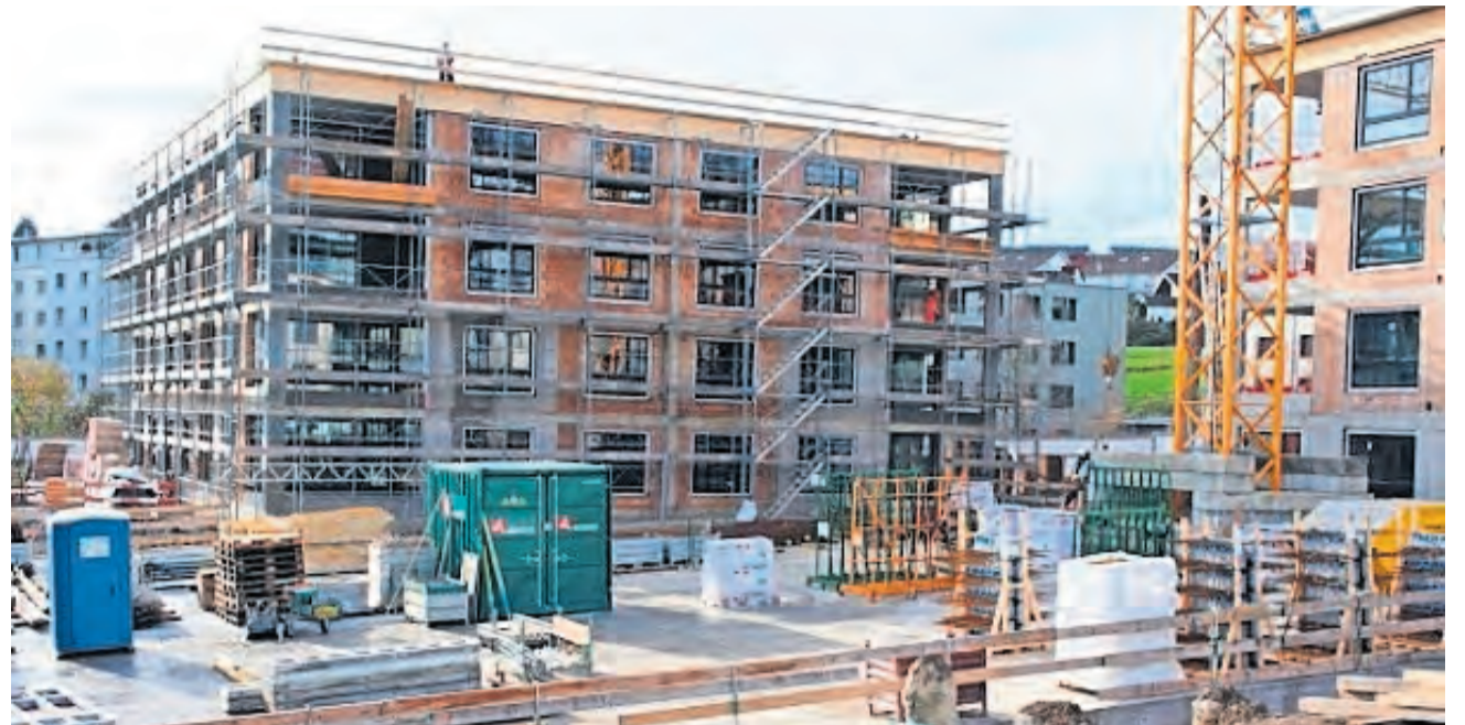
Die beiden Wohnbauten sind bereits im Rohbau vollendet.
