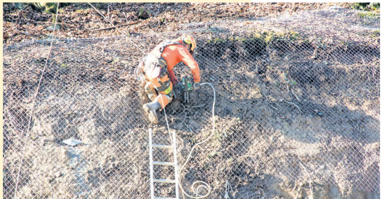
Aufwendig ist die Hangsicherung mit Netzen. Die Verankerungen werden von Hand eingesetzt.
