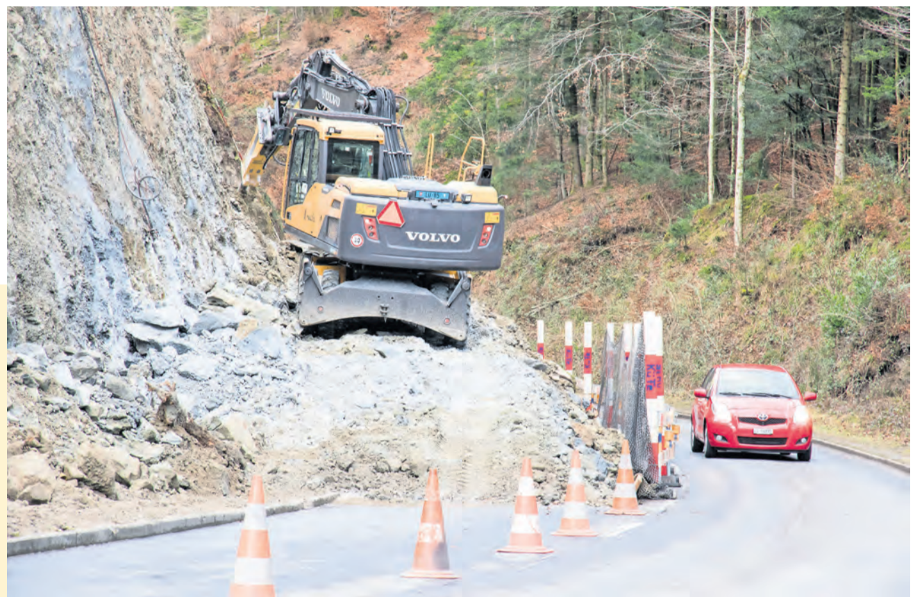
2300 Kubikmeter Fels werden an der Meggerstrasse abgetragen.
