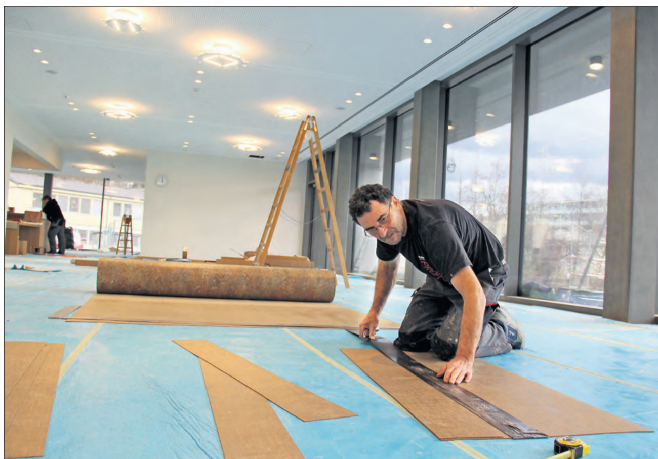
Im künftigen Restaurant sind die Bodenleger an den letzten Arbeiten. Hier werden die Linoleumstreifen für die Treppenstufen zugeschnitten.
