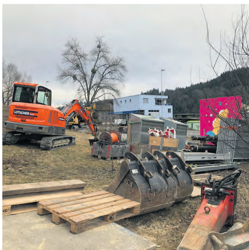
Wegen der Bauarbeiten für die neue Abwasserleitung aus Udligenswil war die Brache bis vor kurzem (auch) eine Baustelle.
