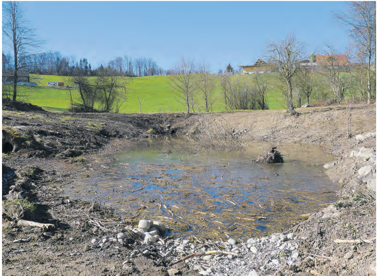
Der neue Blankweiher dient auch dem Hochwasserschutz.
