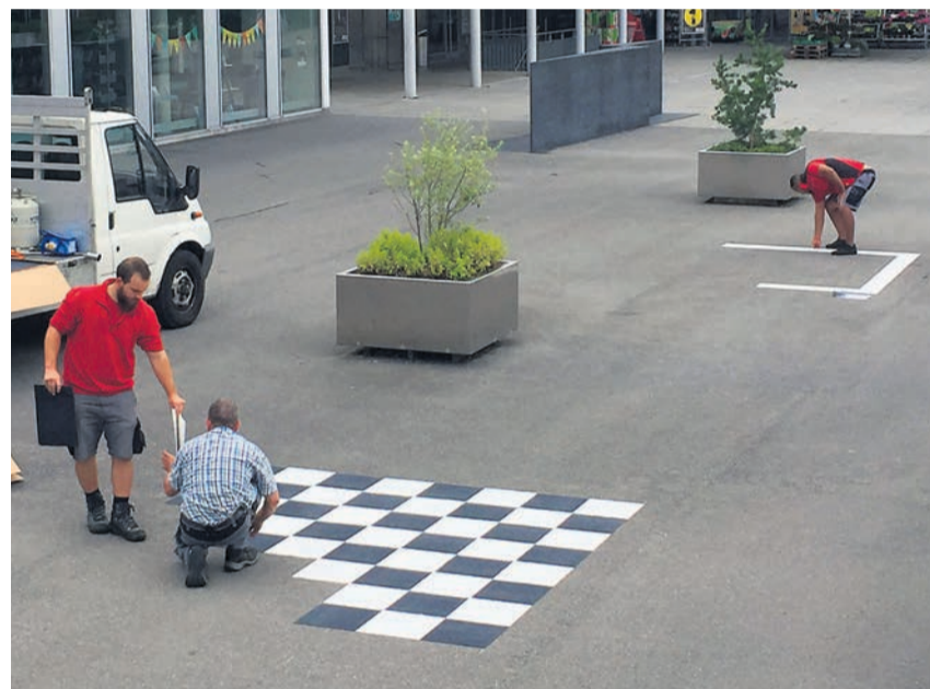
Auf dem Zentrumsplatz werden die Spielfelder angebracht.
