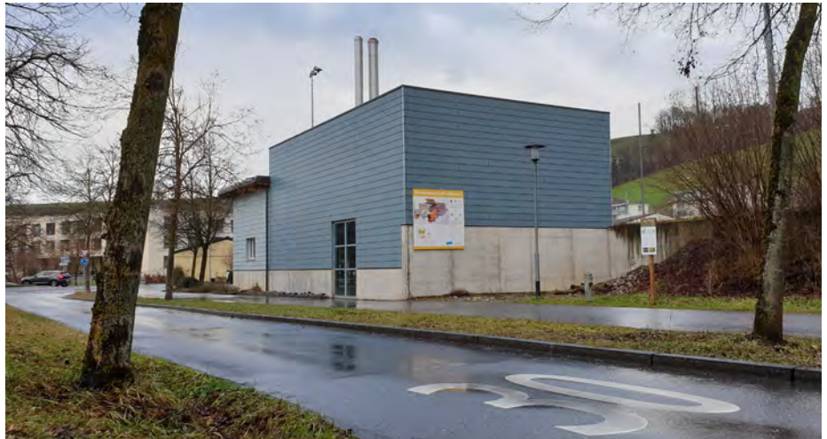
Das Gebäude der Heizzentrale bleibt im Besitz der Gemeinde Adligenswil.
