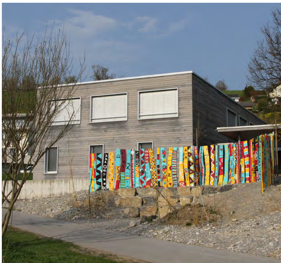
Der noch zeitgemässe Pavillon F der Schulanlage Kehlhof soll erhalten bleiben. Die anderen Pavillons sollen einem Neubau weichen.
