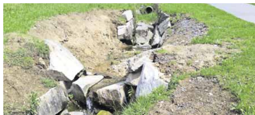
Offener Meteorwasserabfluss Kehlhof nach der Steinentnahme.
