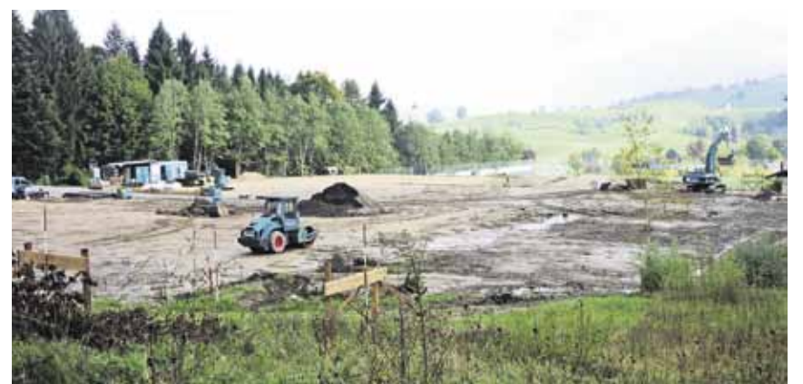
Die Bagger sind aufgefahren.
