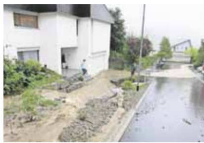
Das Einlaufbauwerk des Lettenbachs im Stiglisrain wird überflutet.
