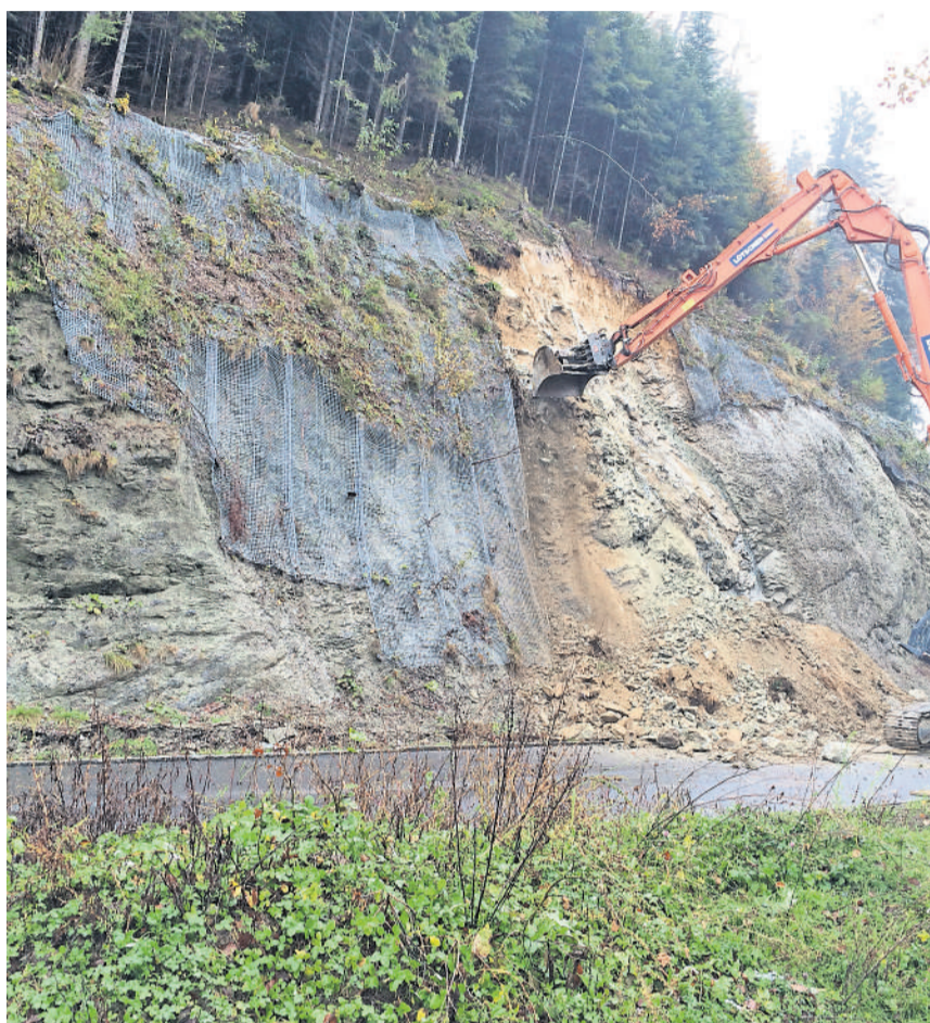
Insgesamt 600 Kubikmeter Material wurden entlang der Meggerstrasse abgetragen.
