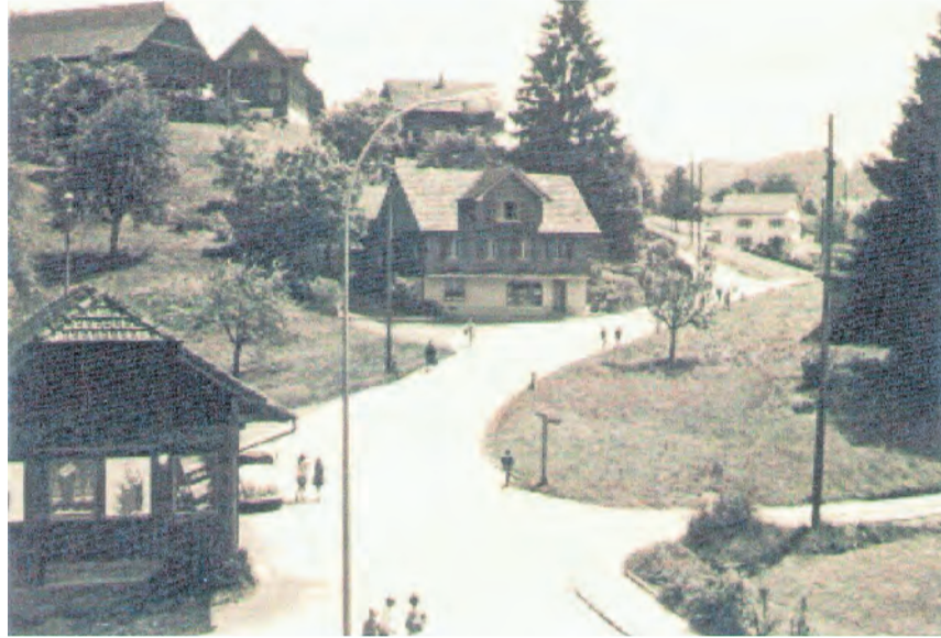
Hinter dem Spritzenhaus der Feuerwehr im Gebiet Obmühle wurde die erste Trafo-Station in Adligenswil erstellt.
