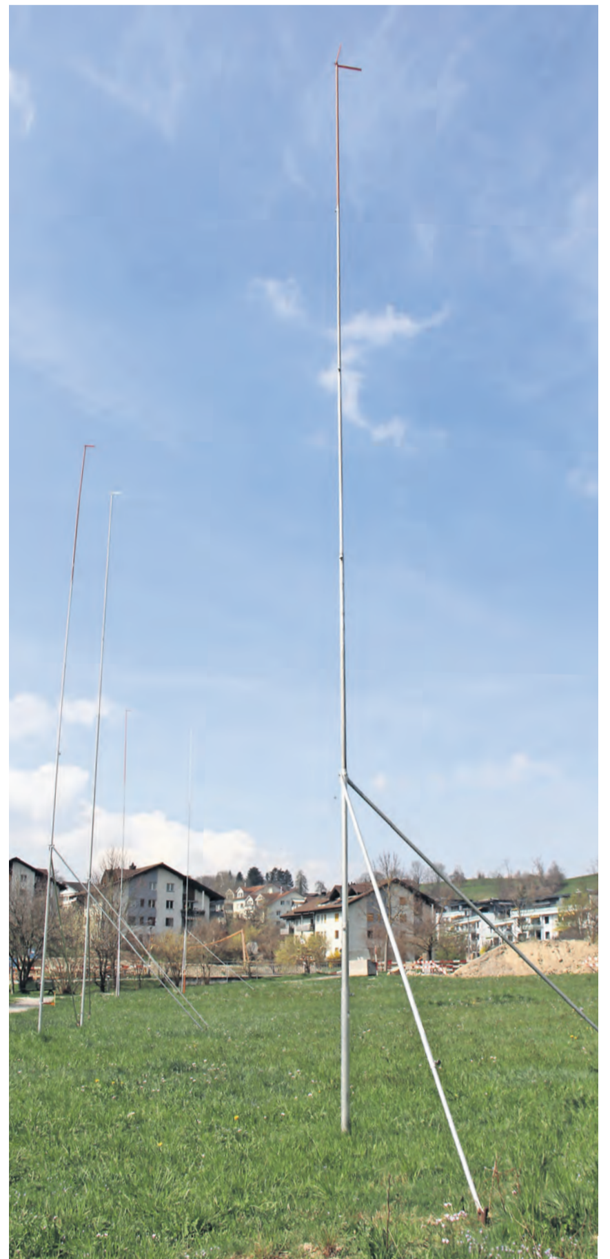
Auf der Wiese im Dorfzentrum steht das Baugespann. Gegenwärtig läuft das Gestaltungsplanverfahren.
