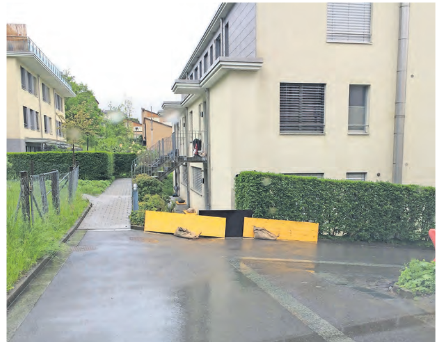
Private Objektschutzmassnahme – hier am Zentrumsweg.
