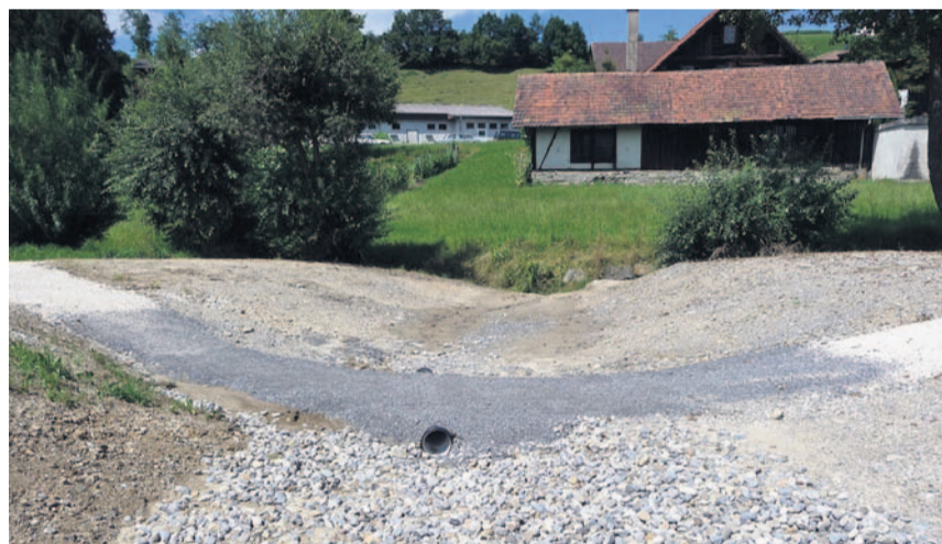
Terrainabsenkung im Bereich «Senke»/Ebnetstrasse.
