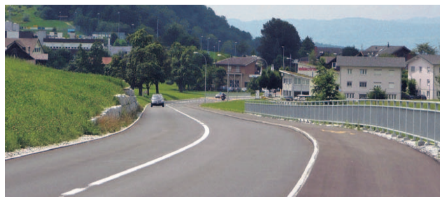
Die Arbeiten an der Ebikonerstrasse sind vollendet.
