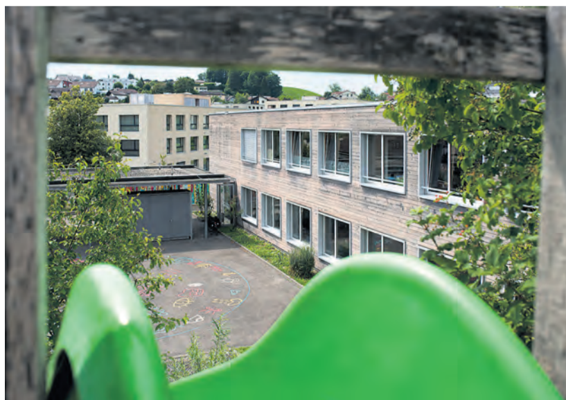
Das neue Schulhaus entsteht im Kehlhof. Die alten Pavillons verschwinden, der neuere Pavillon F (rechts) soll künftig für die Tagesstrukturen genutzt werden.
