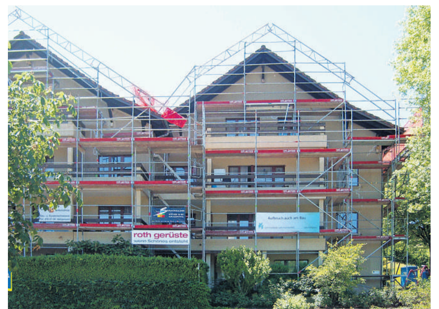
Mitte Juli dürften die Sanierungsarbeiten am «Weiherhof» abgeschlossen sein.
