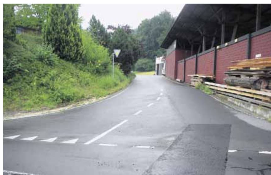
Die Bauarbeiten für die neue Wasserleitung beginnen Anfang September.
