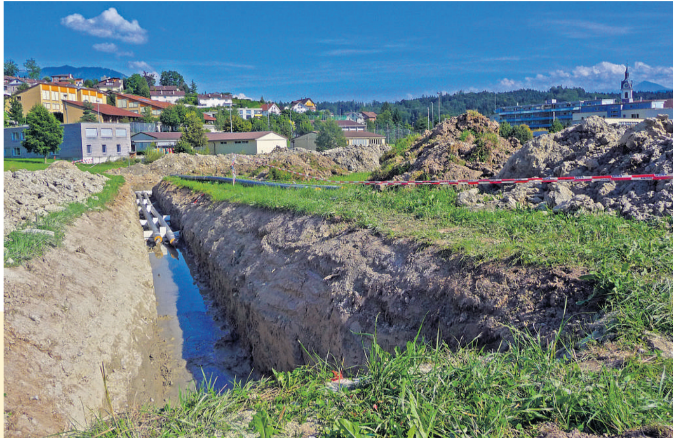
Erweiterung des Fernwärmenetzes der Holzschnitzelfeuerungsanlage.
