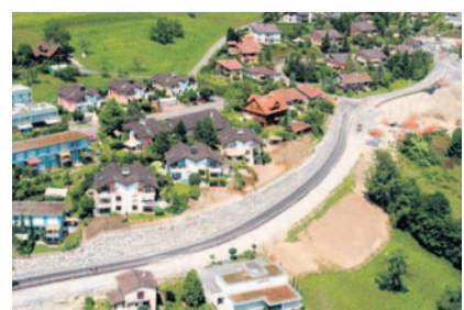
4 Nach Fertigstellung der Block- sätze und der Dammschüttung.
