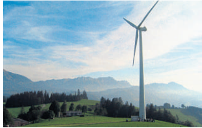
Das Windkraftwerk Entlebuch.
