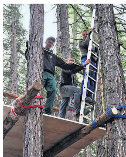
Sie bauten über acht Meter hohe Baumhäuser.
