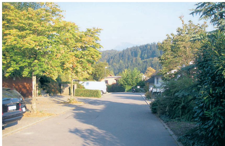
Auf einer Länge von 160 Metern wird hier eine Wasserleitung ersetzt.
