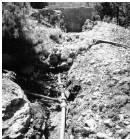
Diese Wasserleitung konnte dank Adligenswil gebaut werden.
