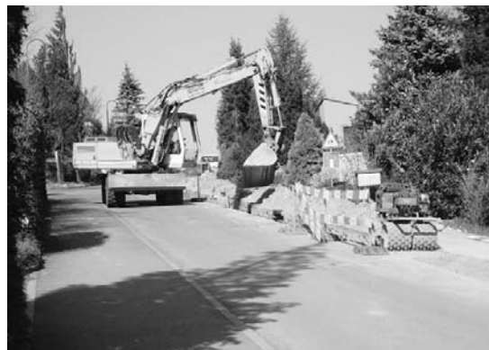
Wasserleitungersatz an der Sonnmattstrasse.
