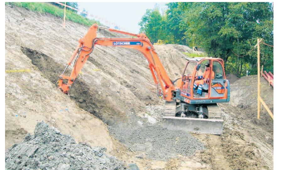
Verzahnung der Entwässerungsgräben auf die Moräne wird erstellt.
