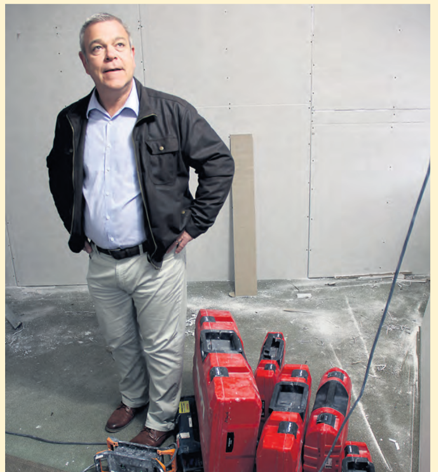
Sozialvorsteher Ferdinand Huber inspiziert den Baufortschritt.
