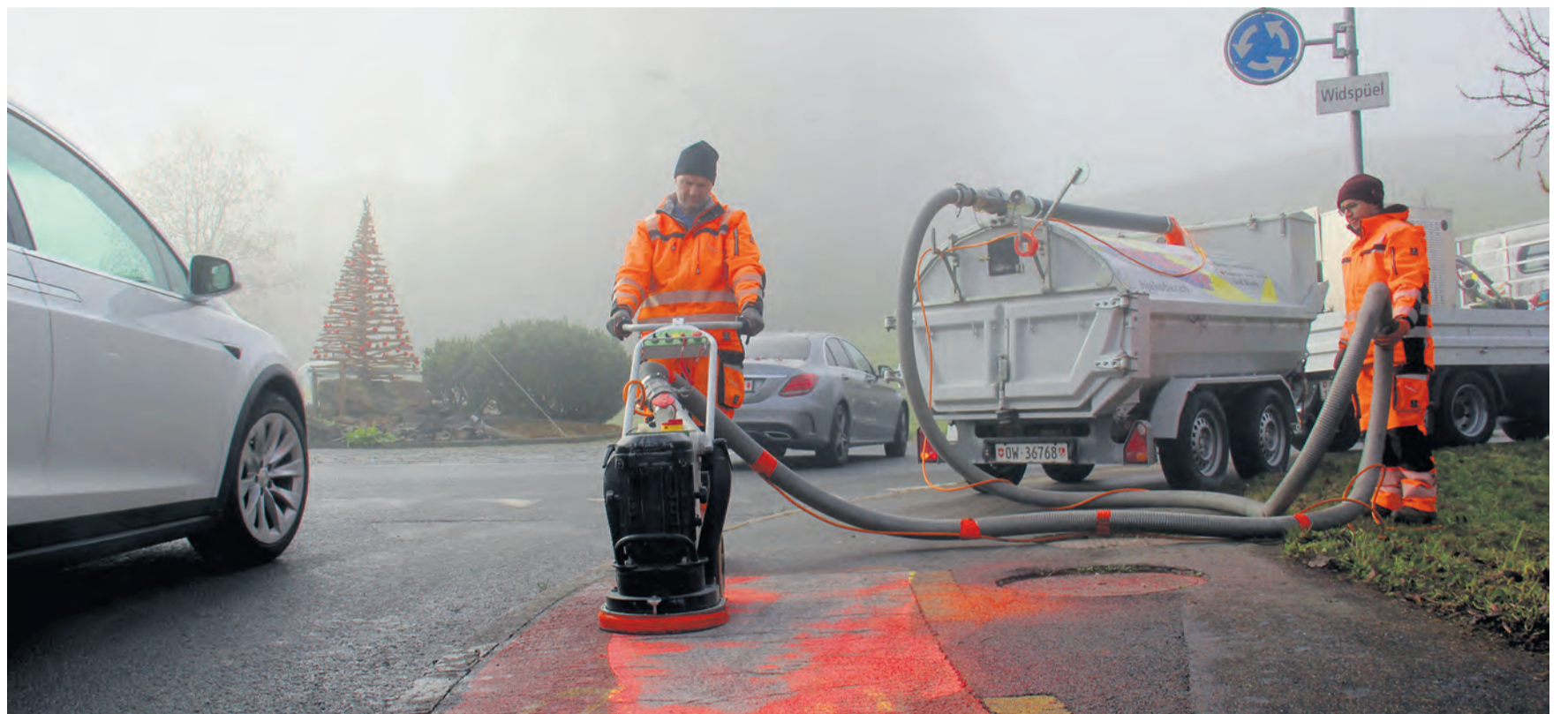
Beim Widspüel-Kreisel wurden die Signalisationen für die Velofahrer auf den Trottoiren entfernt. Neu wird der Veloverkehr durch den Kreisel geführt.
