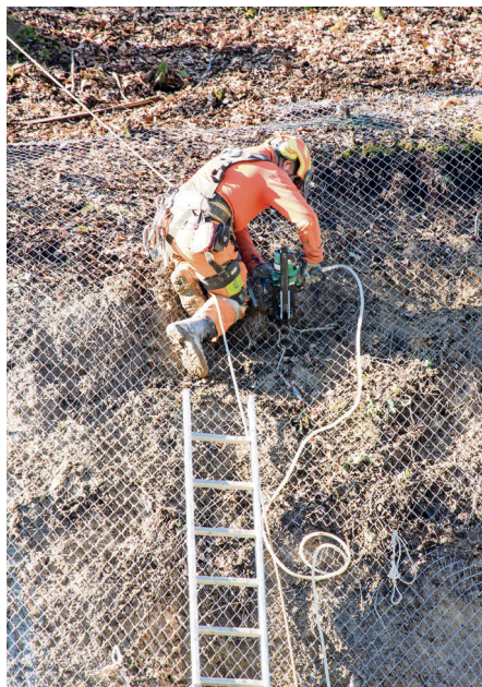
Bei der Sanierung wurden 2018 auch die Felswände entlang der Meggerstrasse gesichert.
