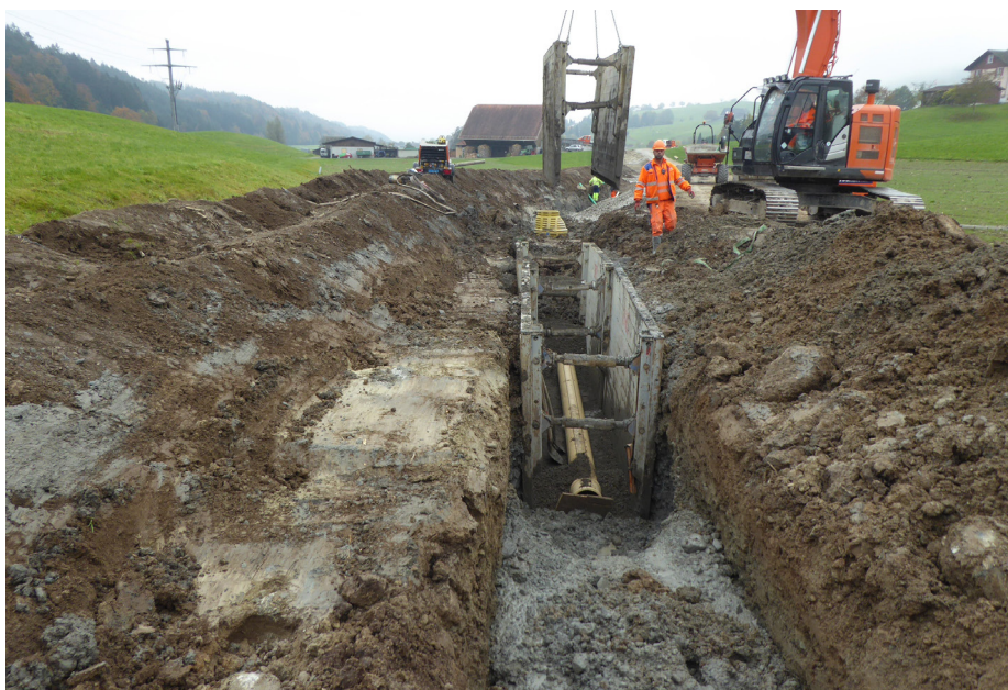
Im Winter 2021/22 wurde die neue Abwasserleitung zwischen Udligenswil und Adligenswil gebaut.
