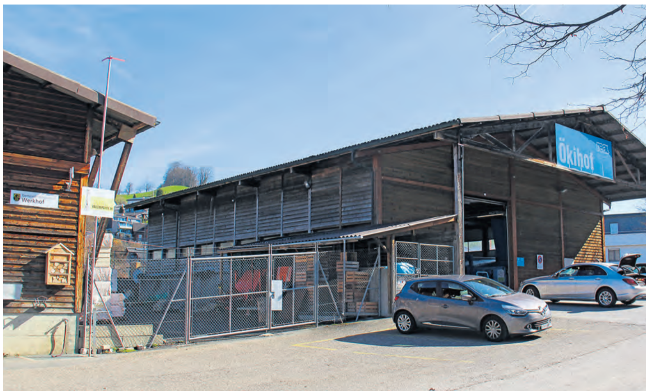
Zwischen dem Ökihof (rechts) und dem Werkhof (links) wird ein Verbindungsbau erstellt.
