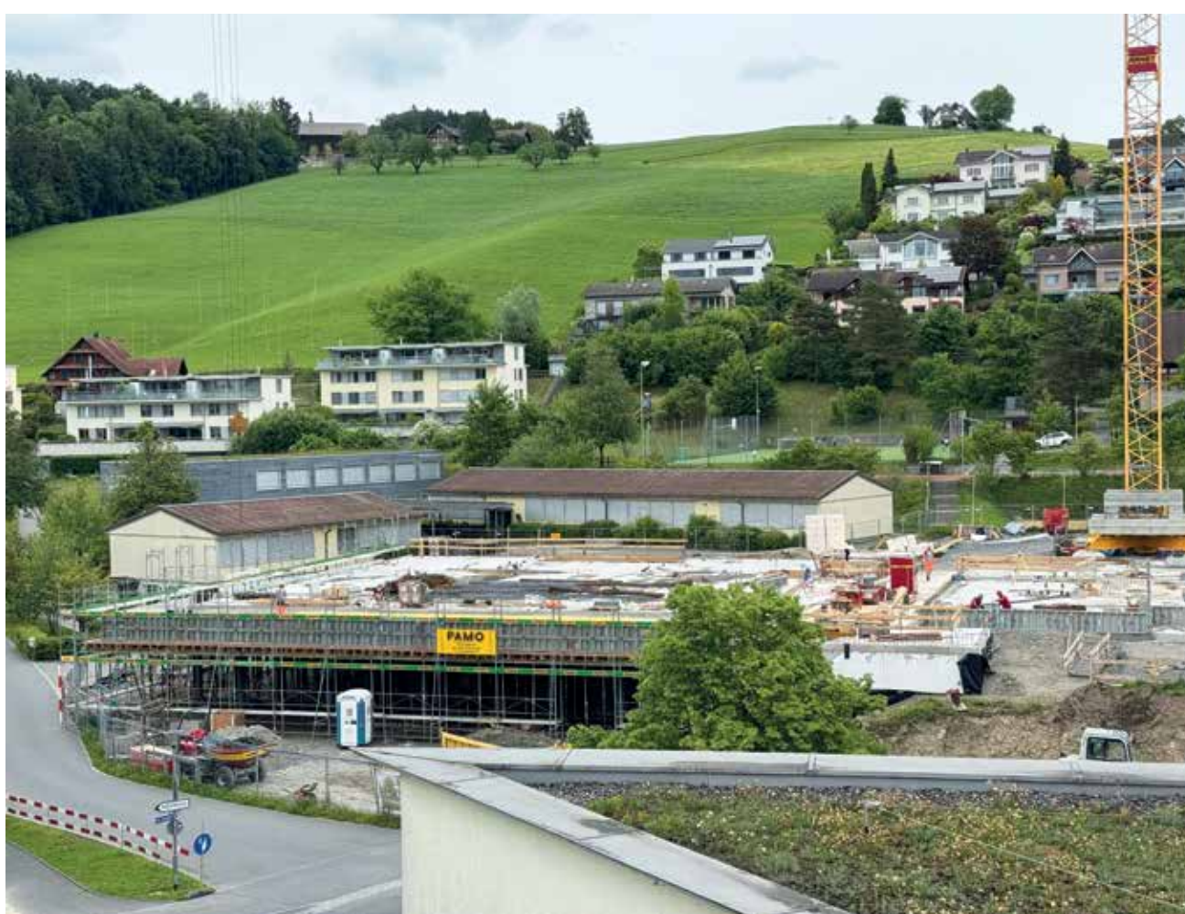
Der Neubau der Schulanlage Kehlhof ragt mehr und mehr in die Höhe.
