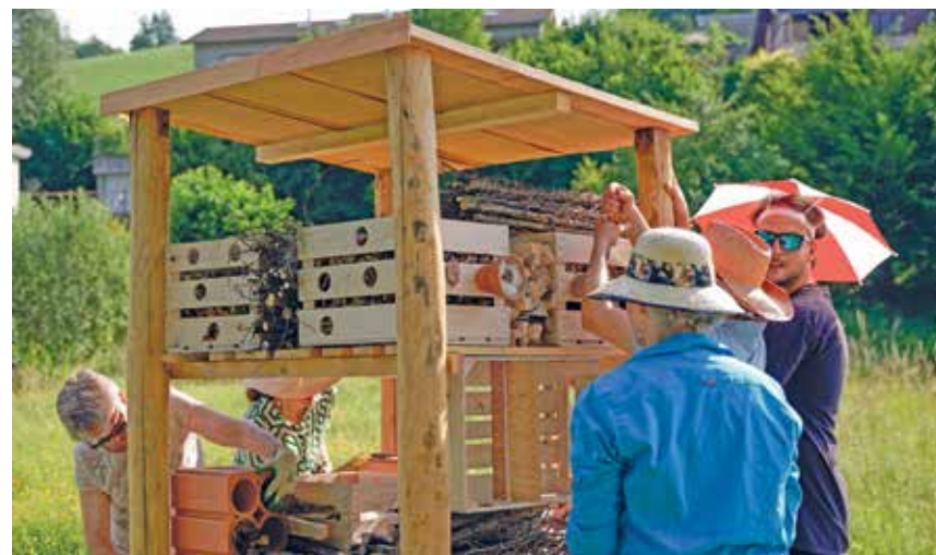
Eine Gruppe von Mitarbeitenden beim Bau eines Lebensturms.
