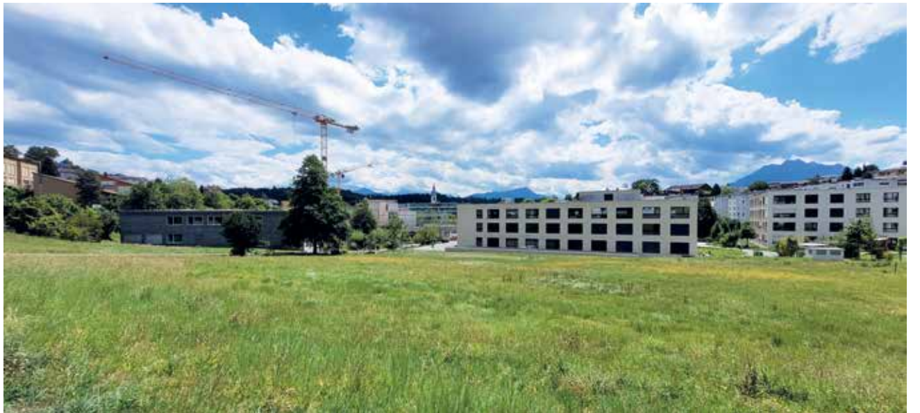
Auf der Brache 909 hinter dem Alters- und Gesundheitszentrum soll eine Doppelturnhalle entstehen.
