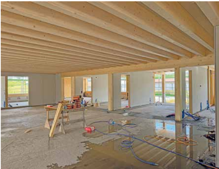
Blick auf den Baufortschritt im Innern des neuen Schulhauses sowie von aussen.
