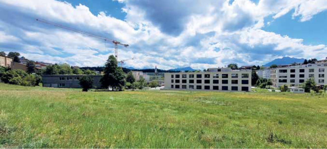
Auf der Brache 909 hinter dem Alters- und Gesundheitszentrum soll eine Doppeltturnhalle entstehen.
